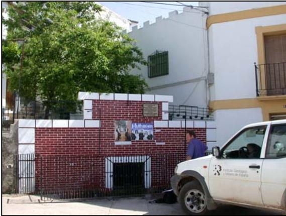
Tiene un caudal que oscila entre prácticamente cero y 60 l/s con puntas históricas de hasta 200 l/s. La captación consiste en una galería de aproximadamente 1 km de longitud que atraviesa calizas del Lías inferior.
